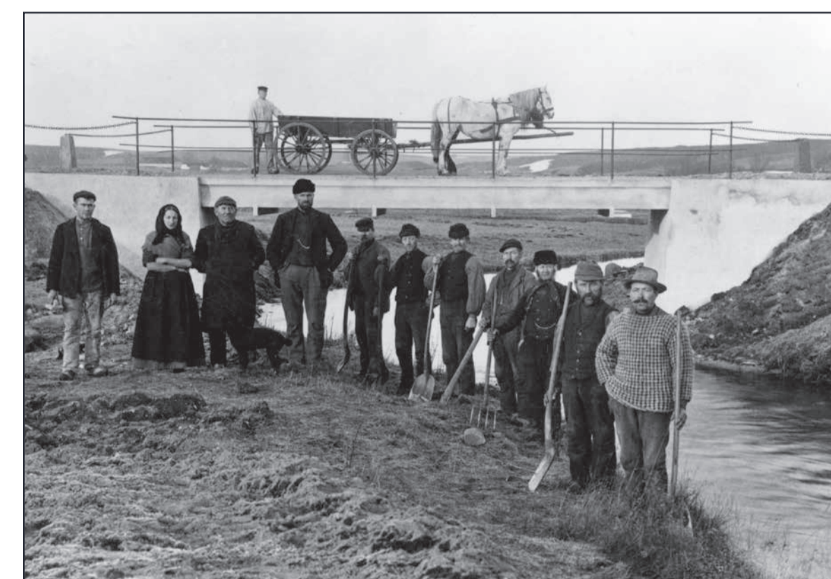
Arbejdshold ved Håls bro, 1895.
